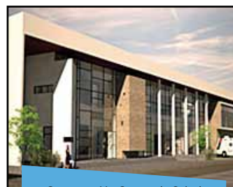
Construcción Centro de Salud Familiar La Calera En ejecución
