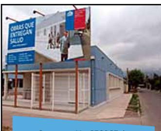
Construcción CECOSF de Nogales, Quillota y La Calera Terminados
