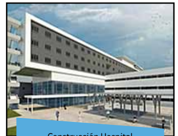
Construcción Hospital Biprovincial Quillota-Petorca inicio de obras
