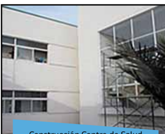
Construcción Centro de Salud Familiar Ocoa y Posta de Salud Rural el Romeral, Hijuelas construidos
