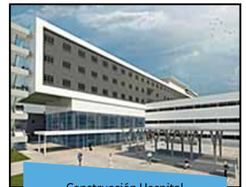
Construcción Hospital Biprovincial Quillota-Petorca inicio de obras
