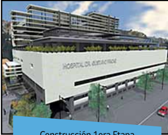
Construcción 1era Etapa Hospital Dr. Gustavo Fricke en ejecución
