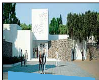
Construcción CESFAM Papudo en marcha blanca
