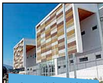
Construcción Centro de Salud Familiar de La Ligua Entregado
